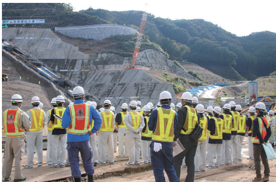
▲ダム本体工事を間近から見学
