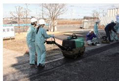
アスファルト舗装工事の実習
