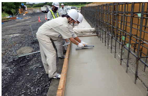
コンクリート小手仕上げ(体験)
