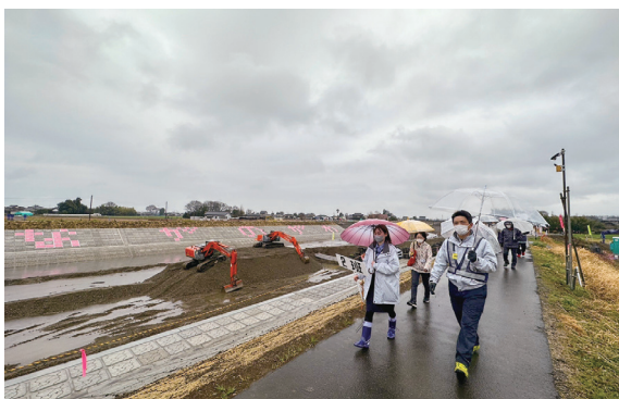
堤防をウォーキングしながら工事現場を見学する参加者
