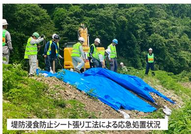
堤防浸食防止シート張り工法による応急処置状況
