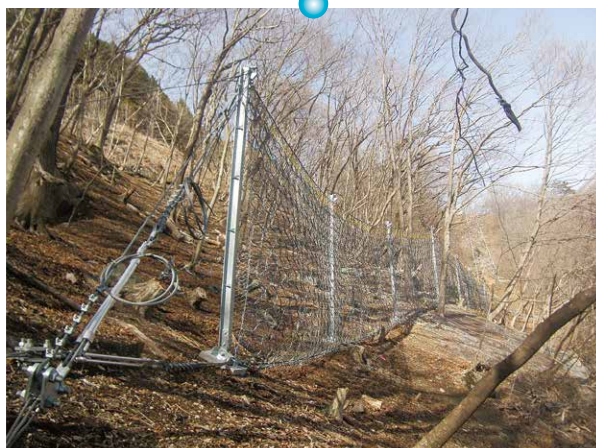
落石防護柵を設置しています。
