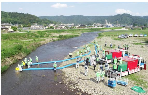
令和6年5月21日に佐野市秋山川、葛生大橋上流にて安足土木事務所、わたらせ建設業協同組合、安蘇建設業協同組合合同で排水ポンプ車操作訓練を行いました。この訓練は年1回行っており今後頻発・激甚化する豪雨災害に対応すべく、機動力を生かし浸水被害の解消を迅速に行うためのものです。排水ポンプ車には人力で持ち運べる小型の特殊ポンプを搭載しており、その性能は30m<sup>3</sup>/min(25mプールを約20分で排水可能)、排水距離50m(ポンプ1台あたり)、排水可能水深0.1m以上、車両総重量8,000kg以下(中型運転免許で運転可能)となっています。訓練では安足土木事務所と各協同組合との情報伝達、排水ポンプ車の設置、展開、操作訓練、排水を行いました。
