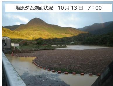
また、三河沢ダム、西荒川ダム、塩原ダム、松田川ダムでは合計668m<sup>3</sup>の流木を捕捉し、ダム下流の流木被害を防止しました。
