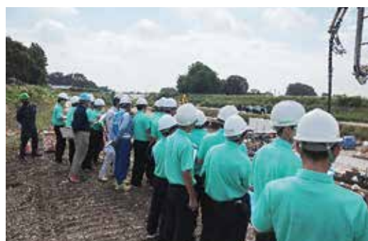
河川工事の作業工程②
