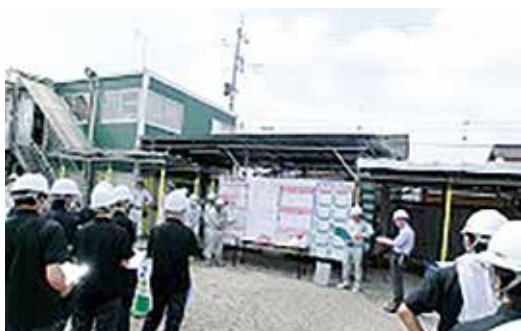
大谷地区工事現場の様子
