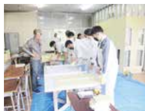
内装工事①
