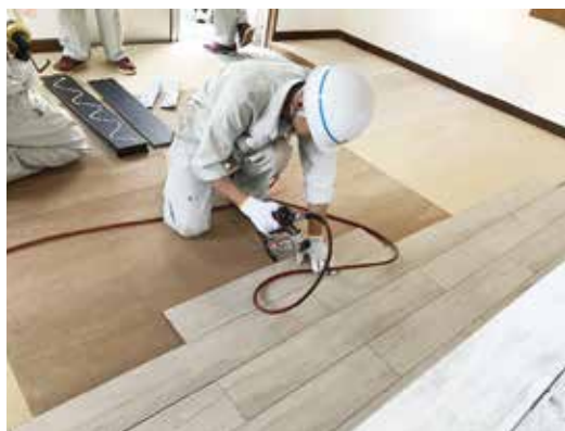
釘打ち機による固定
