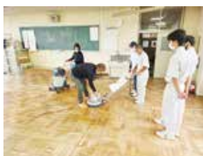
清掃工事①
