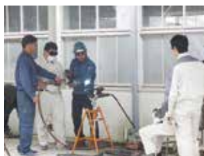
圧接工事②
