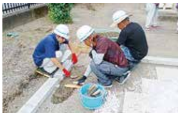
⑪ブロック据付
