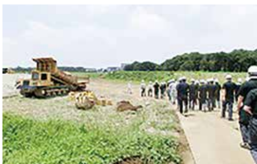
下野市造成工事の様子
