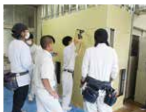
内装工事②
