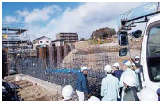
田川岩曽調節池整備工事見学
