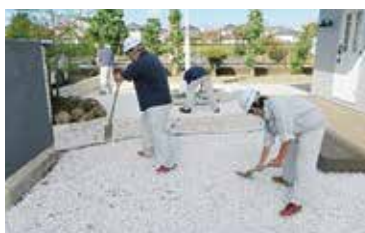
⑭白玉石の敷均し
