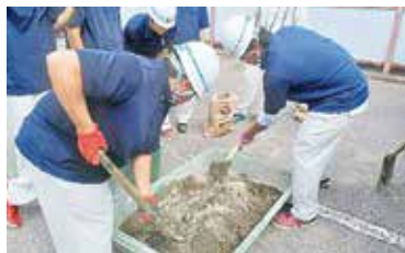
⑩モルタルの練り混ぜ
