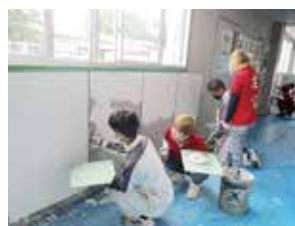
防水工事①
