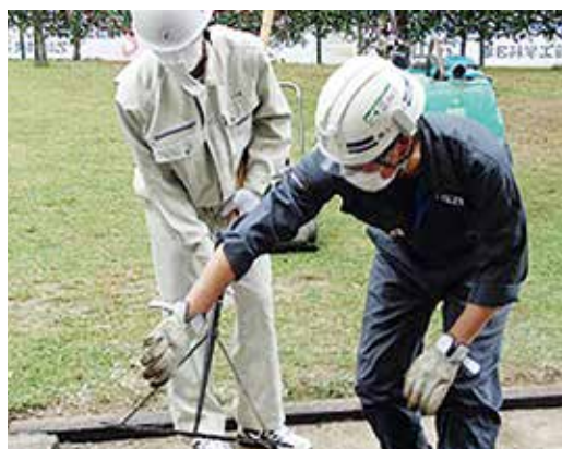
アスファルト合材の敷き均し作業
