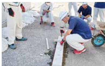
⑦ブロック据付
