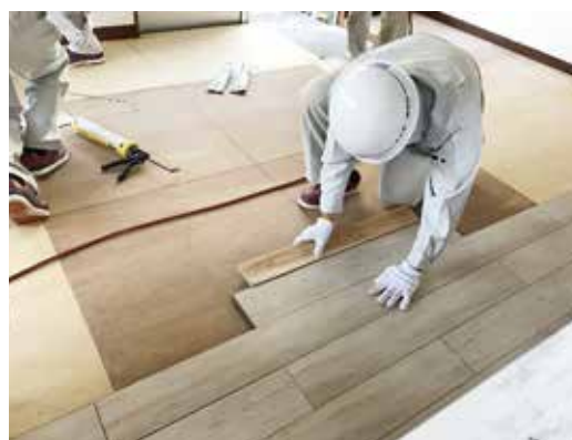
フローリング材のはめ込み
