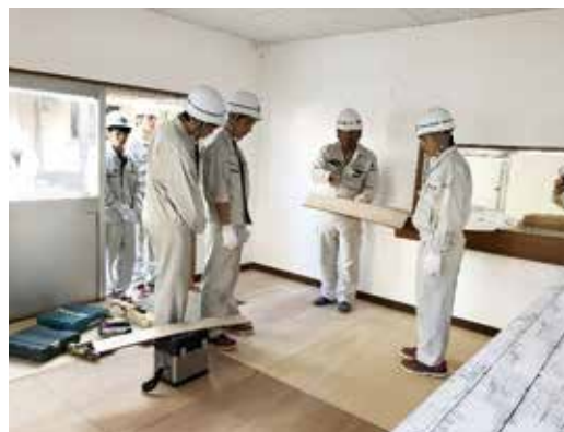
施工手順の説明
