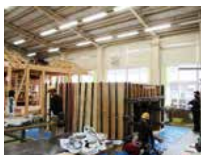
型枠工事②
