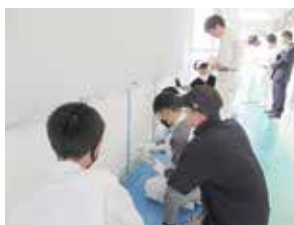
防水工事①
