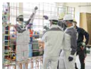
鉄筋工事②
