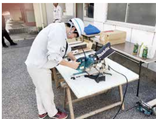
フローリング材の加工
