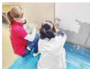
防水工事②
