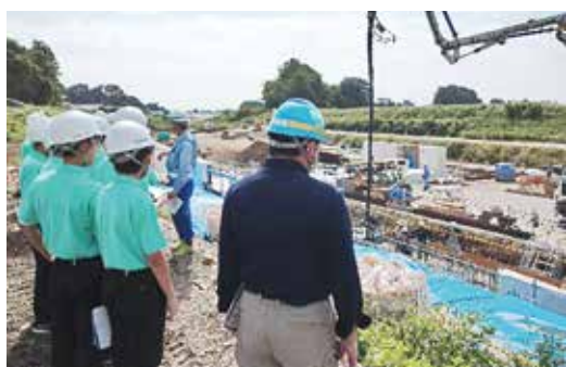
河川工事の作業工程①
