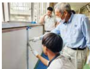
防水工事②
