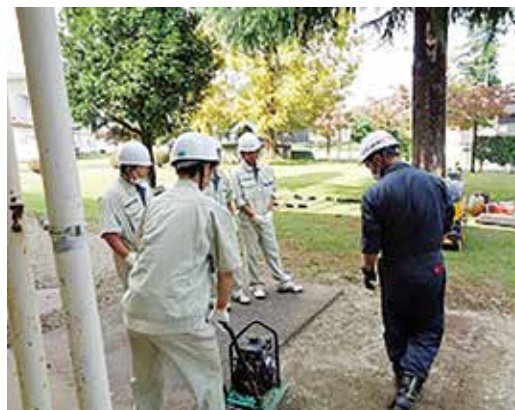
路盤の転圧作業
