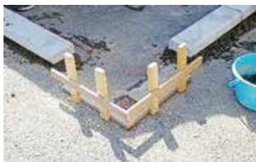
⑧ブロック据付
