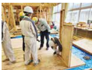
型枠工事①
