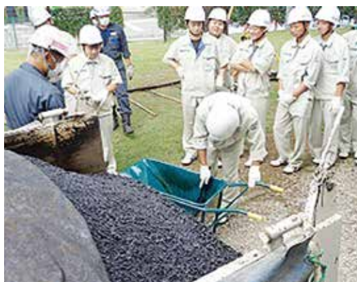
アスファルト合材の運搬作業
