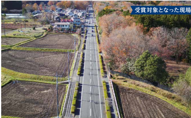
一般県道 日光だいや川公園線の舗装修繕工事完成写真
