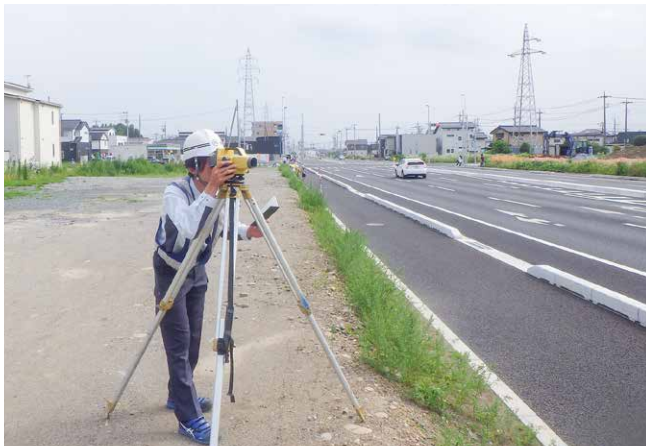
工事を完了し、出来形測量を実施しています。
