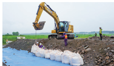
大型土のう積工法設置訓練
