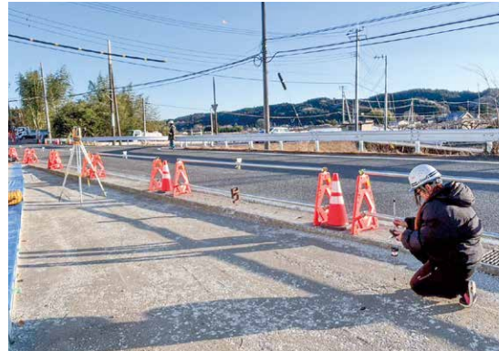
工事測量も一人で行うことに慣れてきました
