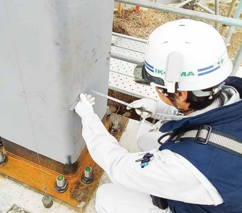
現在従事している現場の鉄骨造の品質管理の状況
