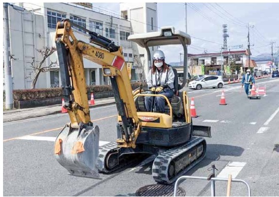
工事中はバックホウに乗り作業を行うこともあります
