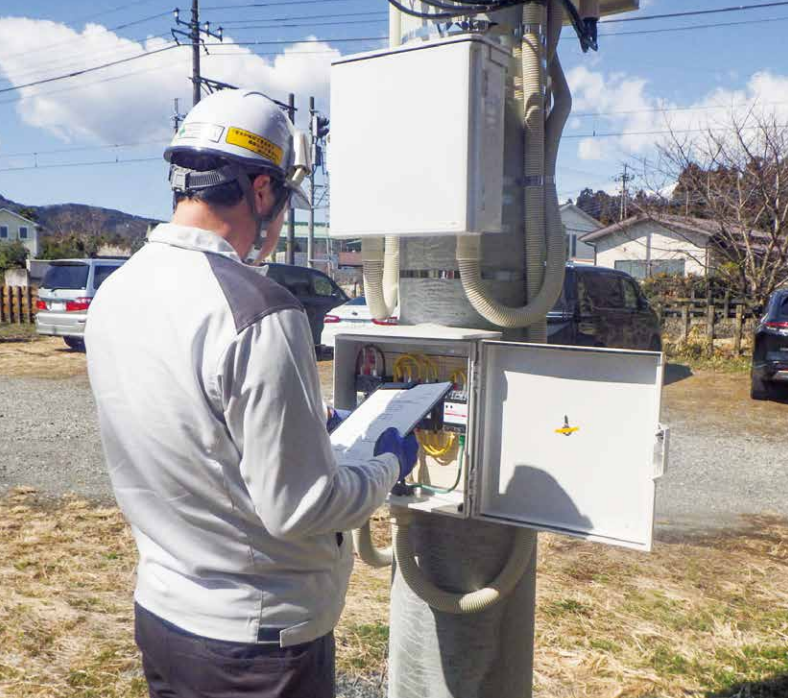
現場での確認作業
