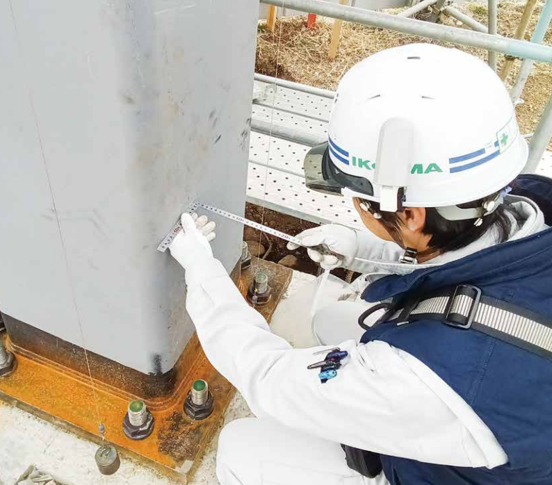
現在従事している現場の鉄骨造の品質管理の状況
