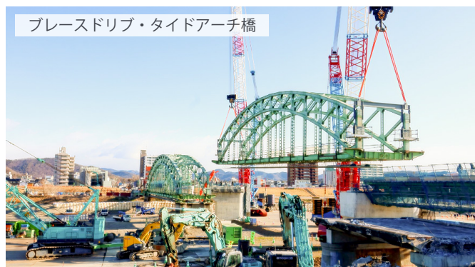
写真2 アーチ移設状況
