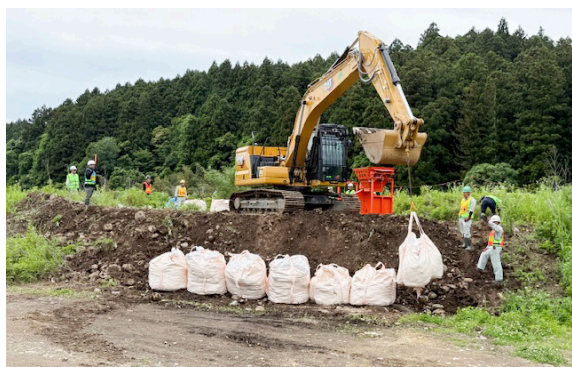
堤防浸食防止大型土のう積工法にて応急処置状況
