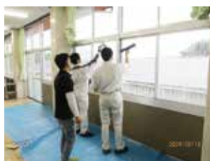
清掃工事②
