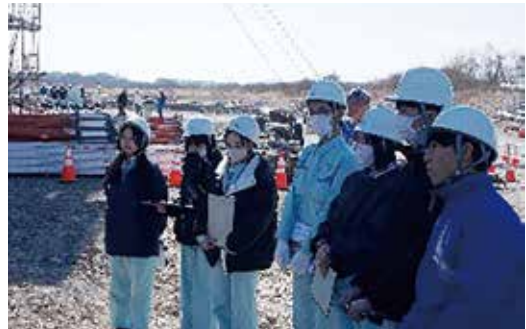
板戸大橋4車線化事業 現場見学③
