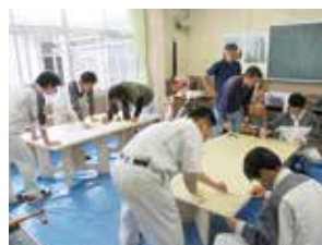
内装工事①
