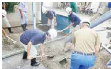
⑩コンクリート打設
