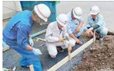
⑥型枠の設置
