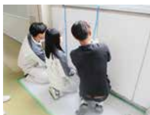
防水工事②
