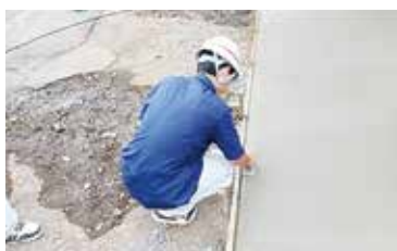
⑭面引き仕上げ
