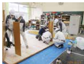
型枠工事①
