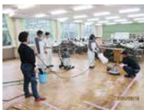
清掃工事①
