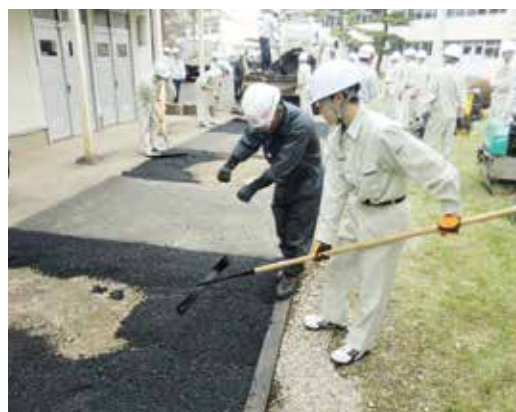
アスファルト合材の敷き均し作業
