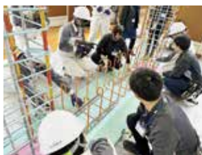
鉄筋工事①
