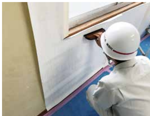
刷毛によるエア抜き
