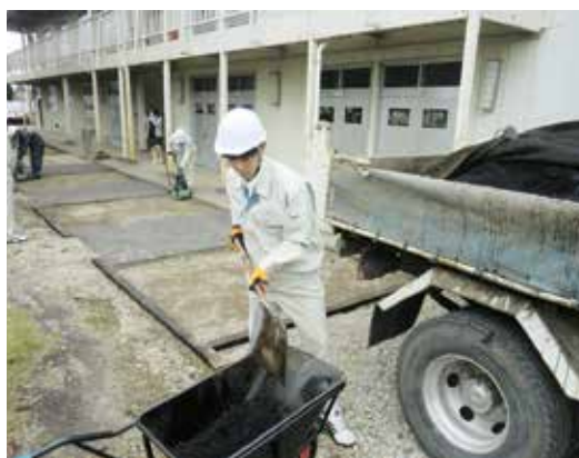
アスファルト合材の運搬作業
