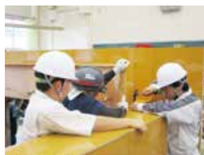
型枠工事②
