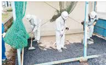
④碎石の敷均し
