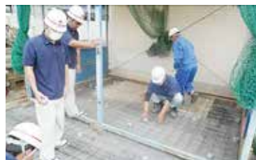
⑨スペーサーの設置
