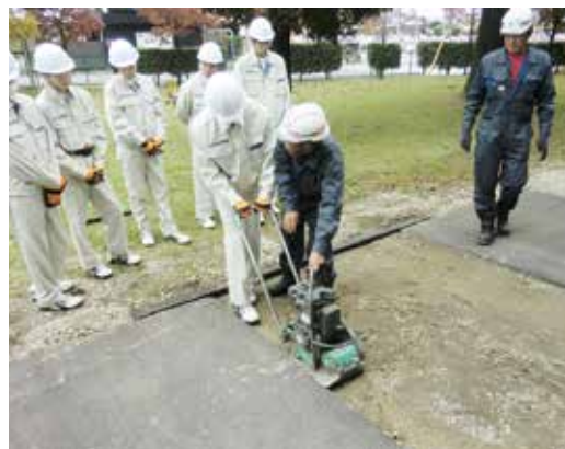
路盤の転圧作業
