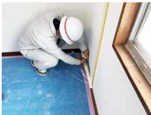
カッターによる切除作業
