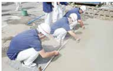
⑪コンクリートの均し
