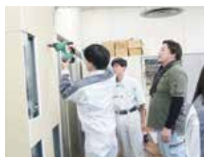
内装工事②
