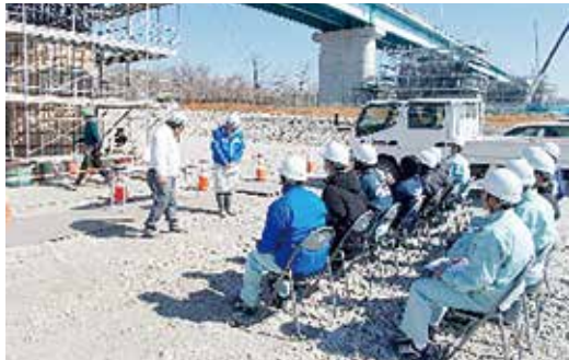
板戸大橋4車線化事業 現場見学②
