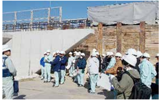
板戸大橋4車線化事業 現場見学①
