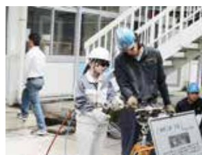
圧接工事①
