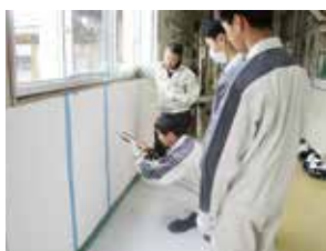
防水工事①
