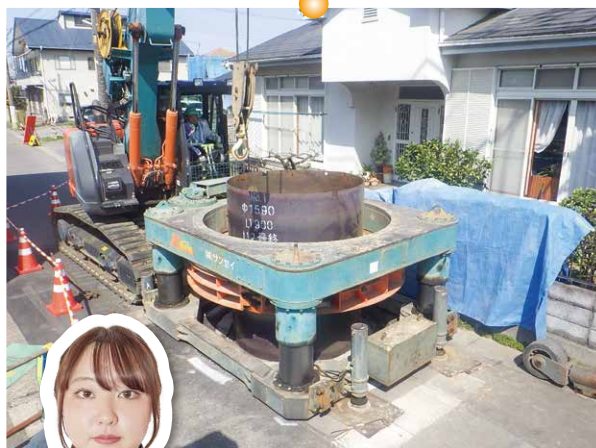
推進用の立坑 施工状況です
