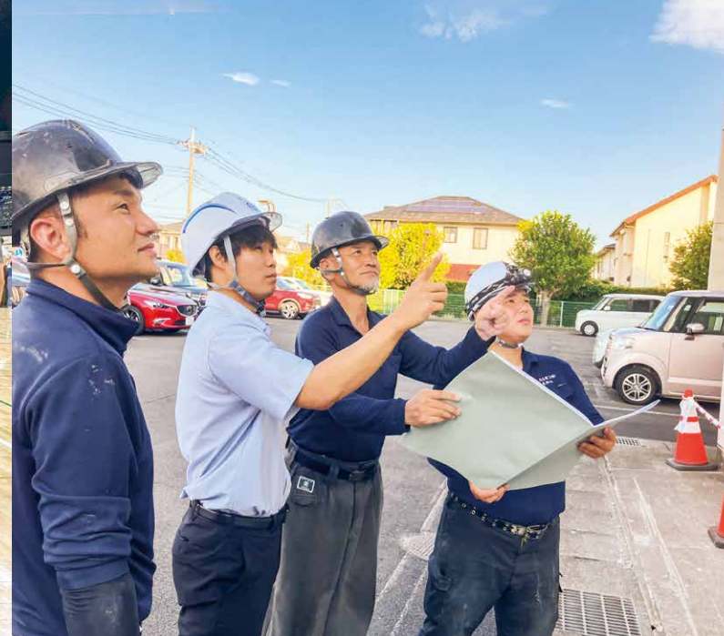
工事現場で職人さんと打ち合わせしている様子(左から2番目)
