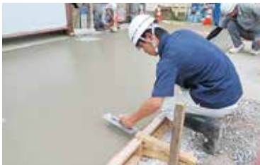
⑪コンクリートの均し
