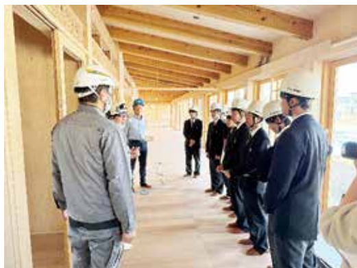
保育園内装工事見学
