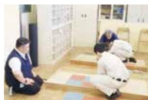
内装工事①
