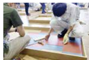
内装工事②
