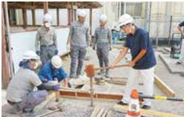
⑥型枠の設置
