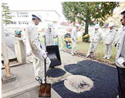
アスファルト合材の運搬作業
