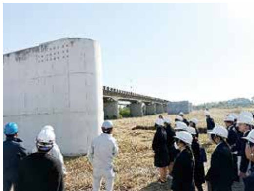
乙女大橋架け替え工事現場見学①
