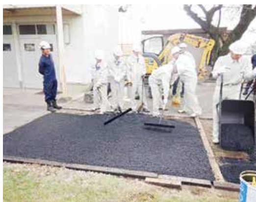
アスファルト合材の敷き均し作業
