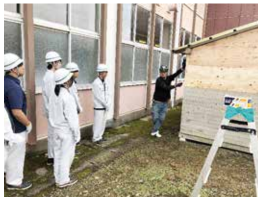
施工手順の説明
