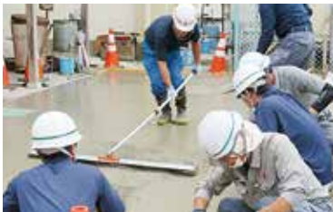
⑫コンクリートの仕上げ
