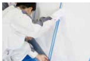
防水工事①
