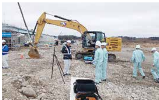
板戸大橋工事現場見学③
