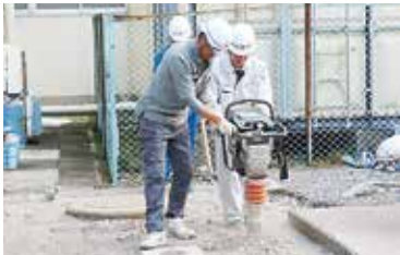
⑤碎石の締固め
