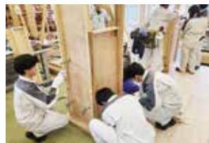
型枠工事①
