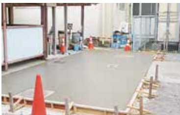
⑭仕上げ完了
