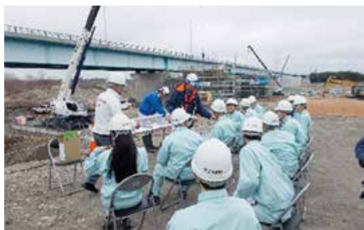
板戸大橋工事現場見学①
