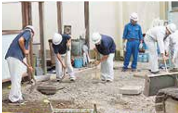
④碎石の敷均し
