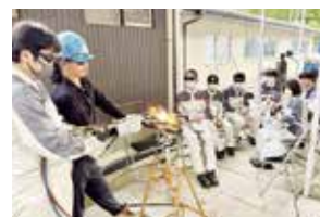
圧接工事②
