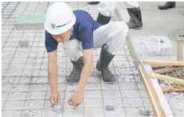
⑨スペーサーの設置
