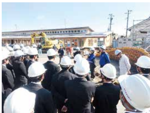
小山市内の保育園建設現場見学
