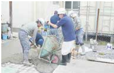
⑩コンクリート打設
