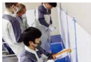
防水工事②
