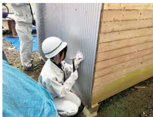
取り付け作業
