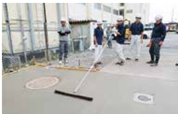
⑬刷毛引き仕上げ
