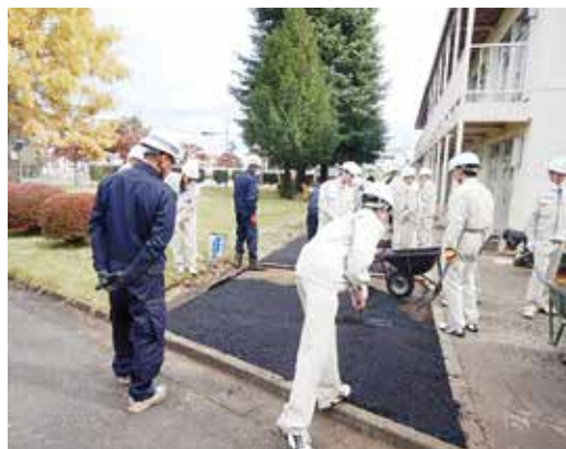
アスファルト合材の敷き均し作業
