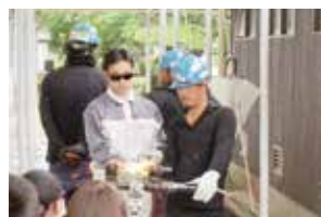
圧接工事①
