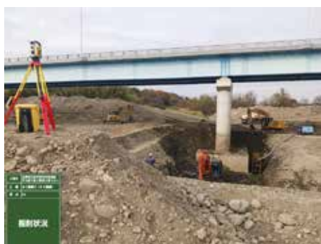
TS-MC施工状況
