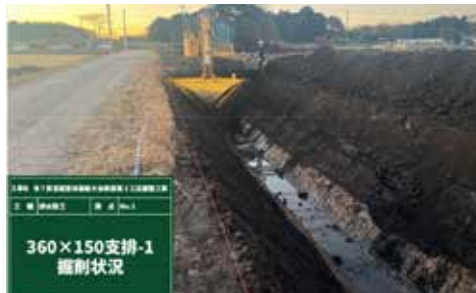
排水路工 圃場用土水路 ICT掘削状況 360×150支排-1
