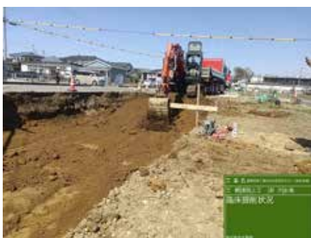
路床掘削状況
