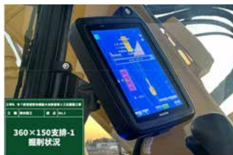
排水路工 圃場用土水路 ICT掘削状況 360×150支排-1
