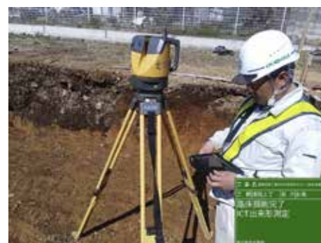
地上型レーザースキャナー 出来形測量
