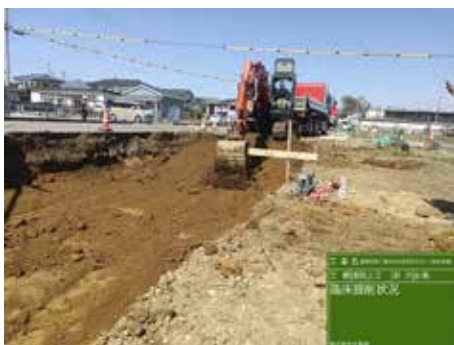
路床掘削状況
