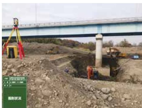
TS-MC施工状況
