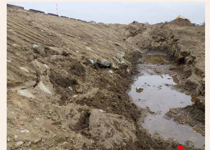
〔護岸工事 永野川〕（栃木市梅沢町大久保橋付近）
