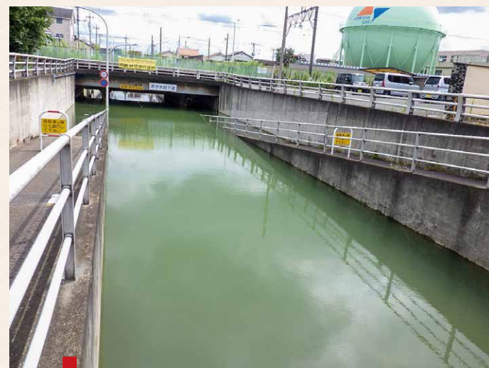
〔排水作業 あずま地下道〕
