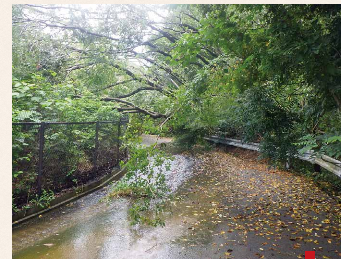
〔倒木・土砂撤去 大岩町〕
