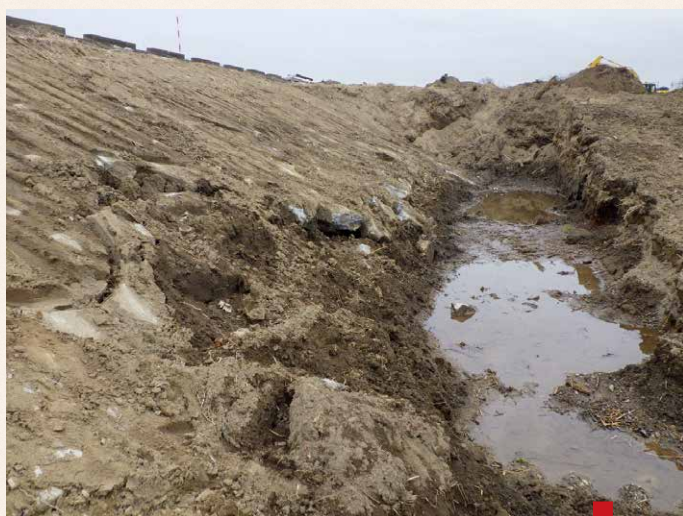
〔護岸工事 永野川（栃木市梅沢町大久保橋付近）〕
